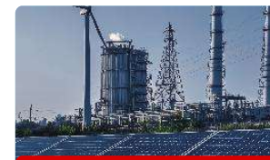
Energie- und Umwelttechnik
