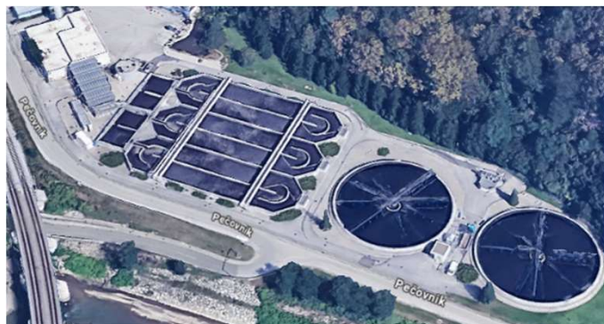
Herkömmliche kommunale Kläranlage in Tremerje
