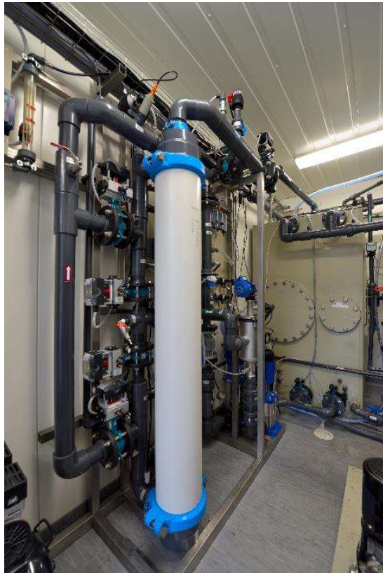
Flockung und Ultrafiltration (dritte Stufe)
