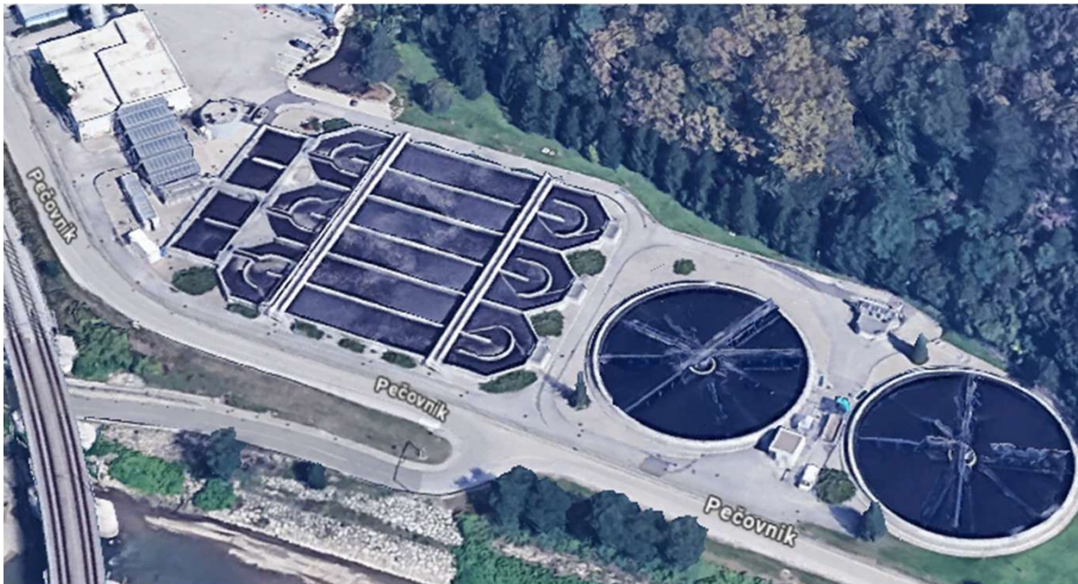
Zweistufige konventionelle kommunale Kläranlage in Tremerje
